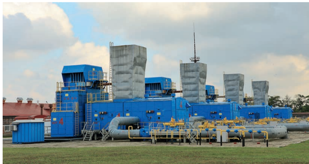
Компрессорная станция «Березанская»
