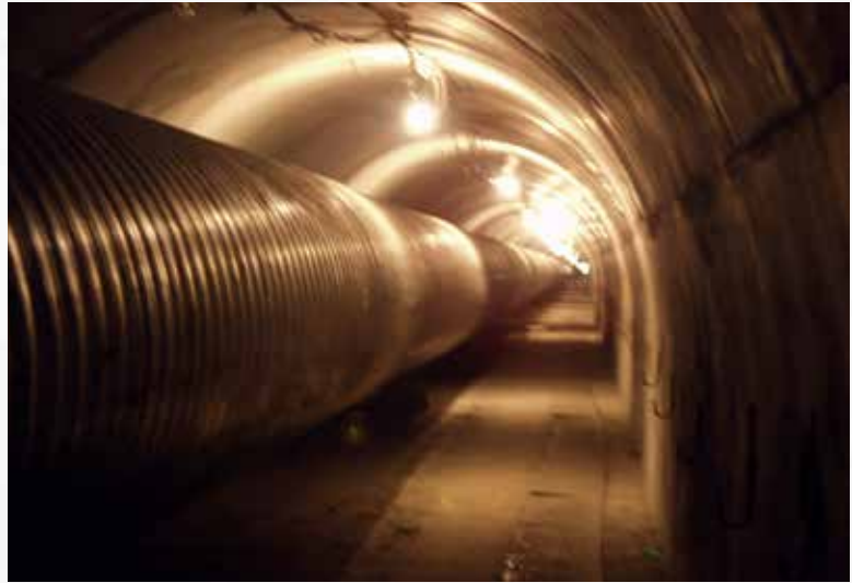
Труба в тоннеле.
