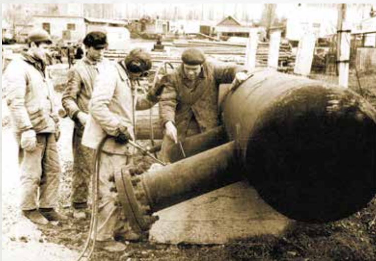
Подготовка подземной ёмкости для хранения одоранта.
