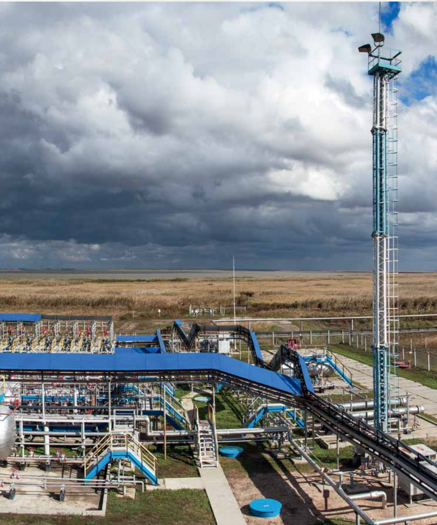
Установка подготовки газа-500 Каневского ГПУ, 2012 г.
