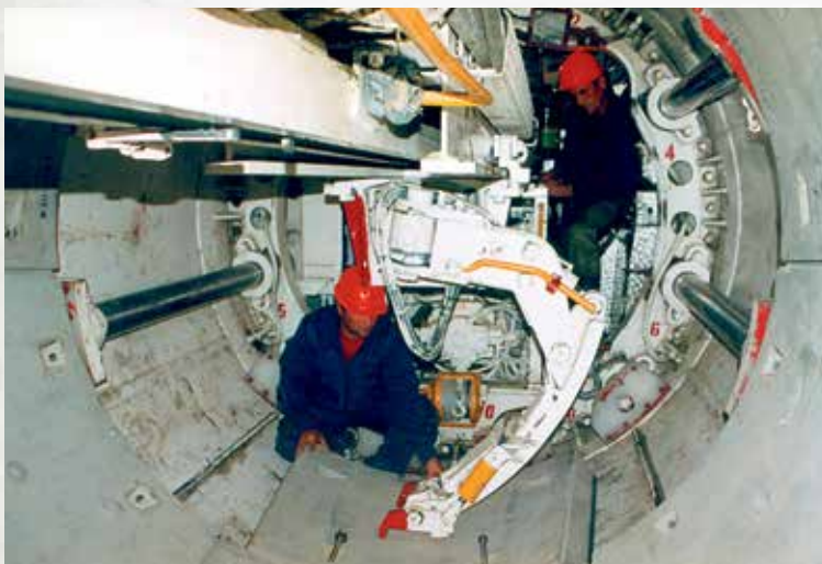
Работы по обустройству тоннеля, хребет Кобылак, 2002 г.
