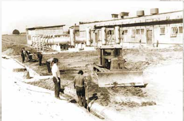
Строительство КС «Березанской».
