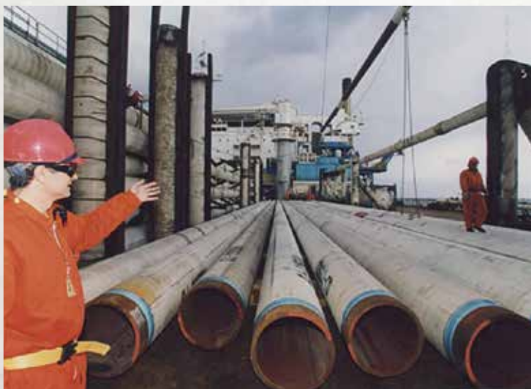
Трубы готовы к укладке на глубину до 2000 м. Трубоукладчик «Сайшем-7000». Чёрное море, 2001 г.
