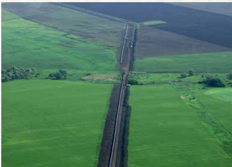
Линейная часть газопровода «Россия – Турция», «Голубой поток».
