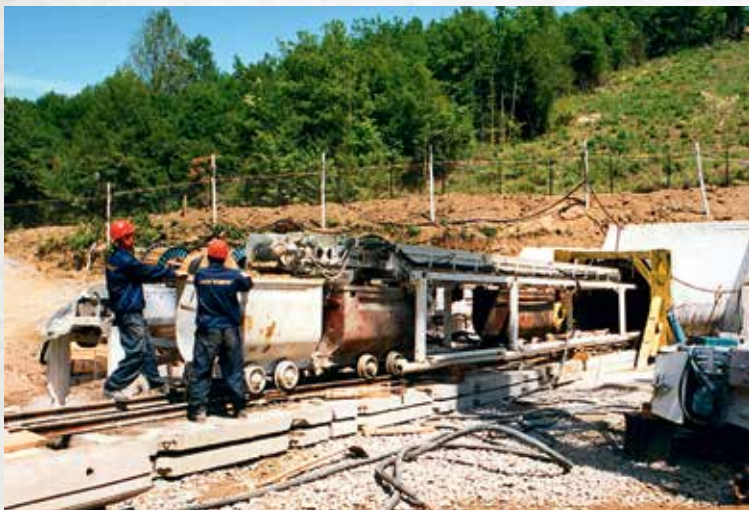
Строительство тоннеля под хребтом Кобылак, 2002 г.
