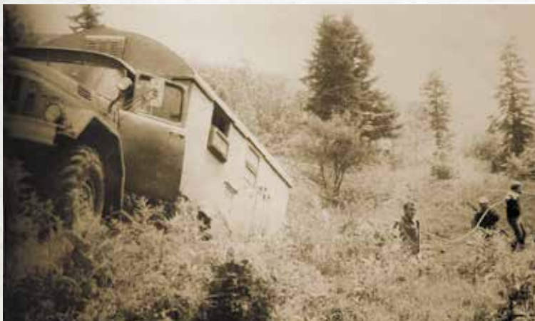
Устранение повреждения на кабельной линии связи «Майкоп – Лазаревское» на участке «Казаевская Поляна – Грачевский Перевал». 1983 г.
