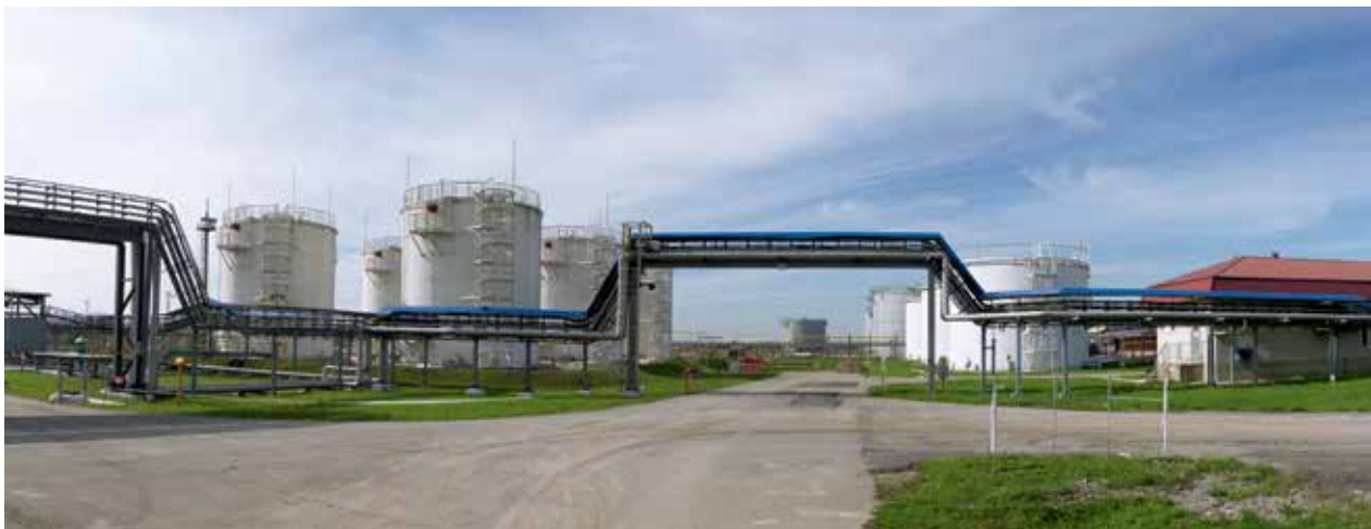
Пункт налива газового конденсата Каневского ГПУ
