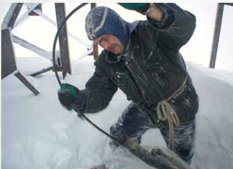
Прокладка кабельной линии связи в зимних условиях на Краснодарском участке.
