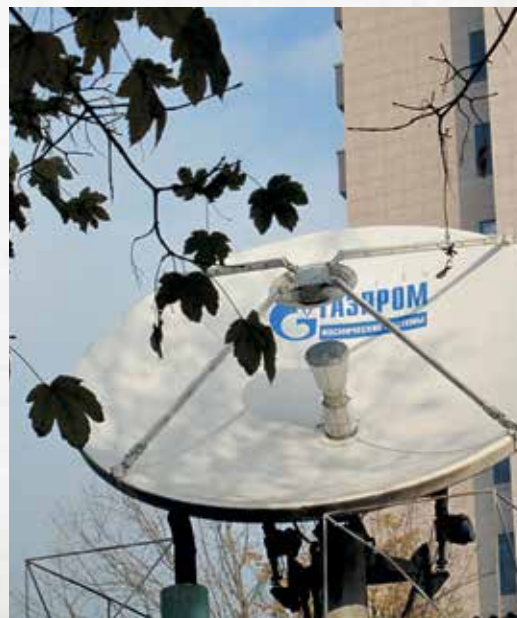
Спутниковая антенна диаметром 3,7 метров для организации канала видеоконференцсвязи со спутника ПАО «Газпром».
