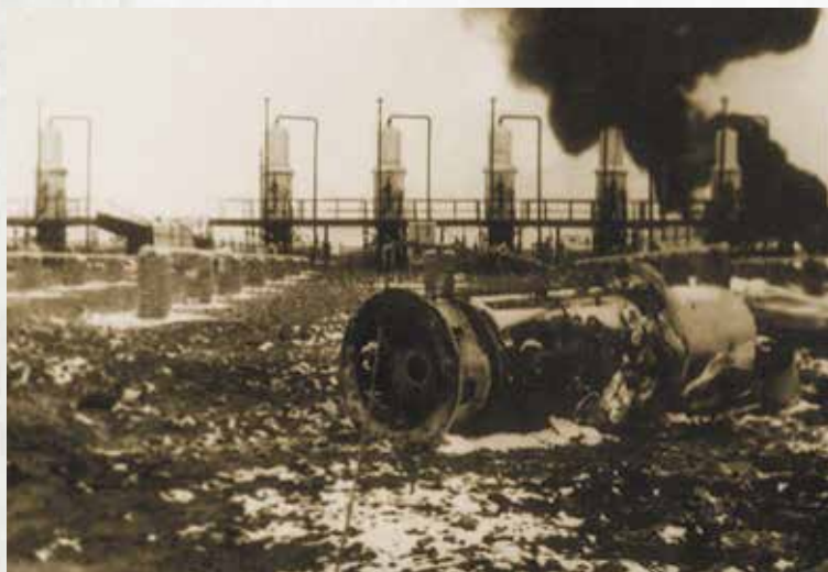
Сепаратор весом 9 тонн, улетевший 7 марта 1962 года на 72 метра (газопромysel №4).
