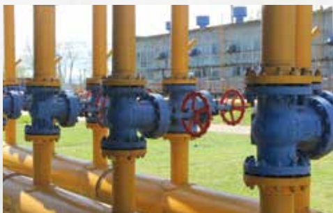
Коллекторы АВО КС «Афипская», 2015 г.
