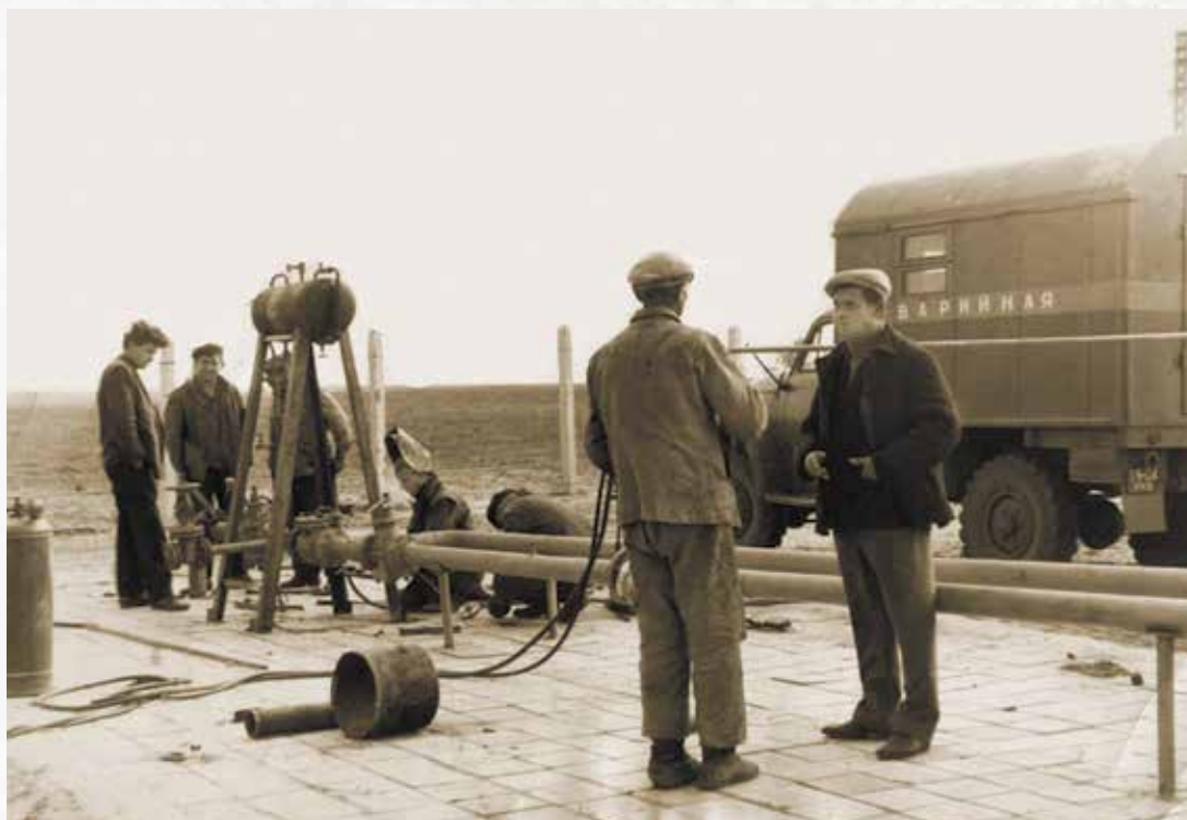
Холмская ГРС Монтаж одоризатора, 1975 г.
