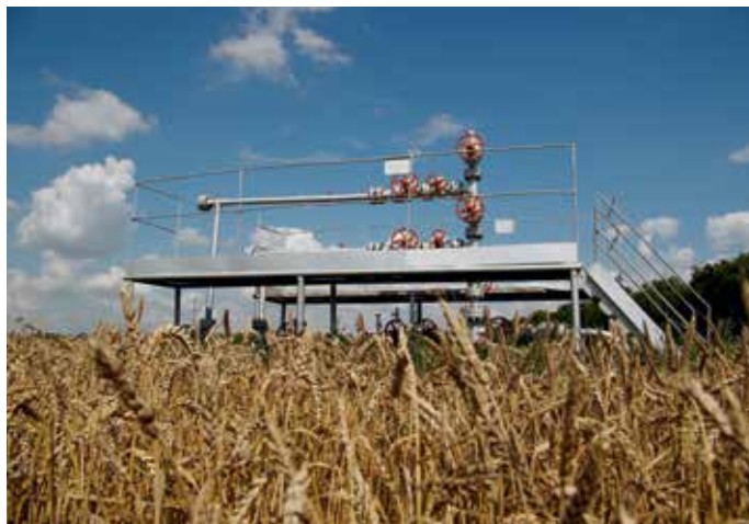
Скважина № 17 Ильинского месторождения Каневского газопромислового управления. 2014 г.
