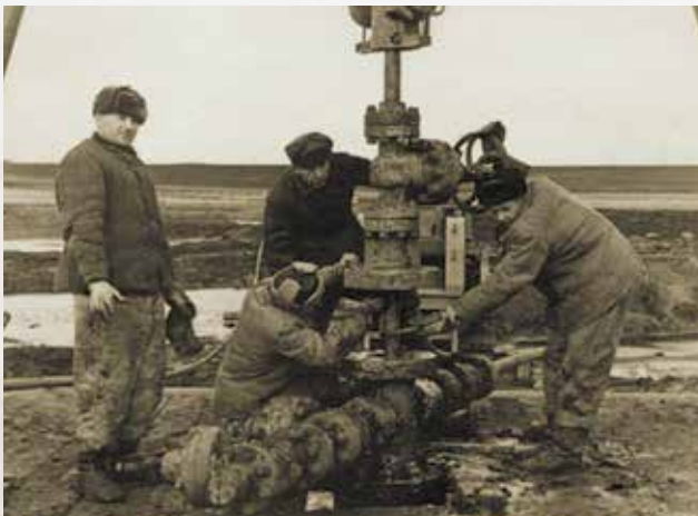
Первый ремонт скважины № 15 (подготовка к пуску в эксплуатацию), 1961 г.
