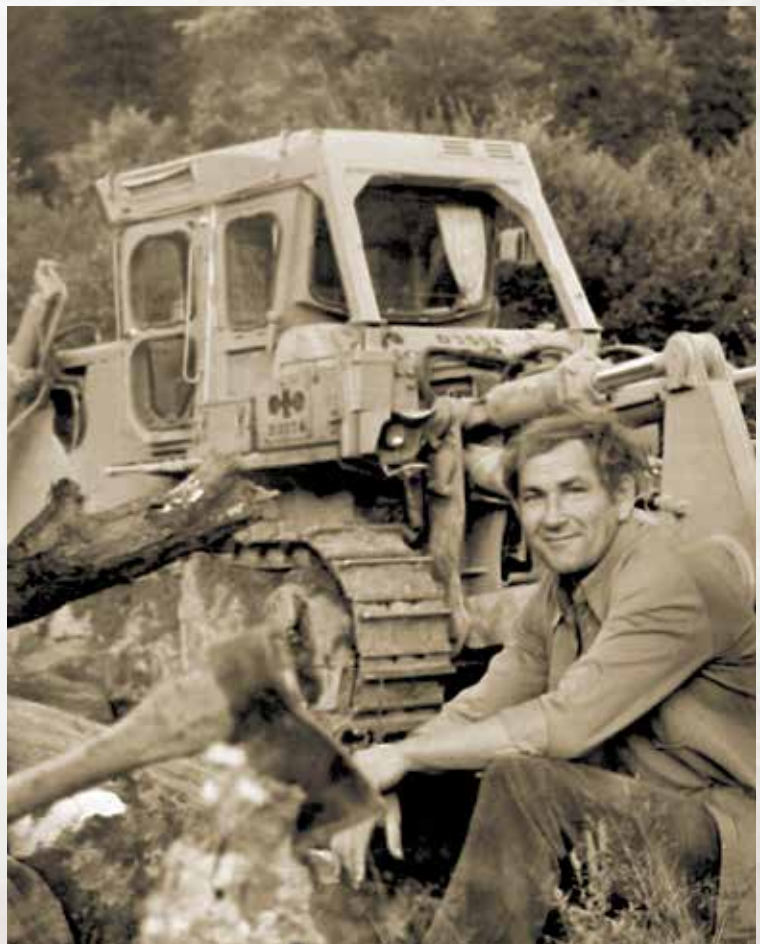
Н. Н. Силин, прокладка кабеля «Майкоп – Сочи», 1983 г.
