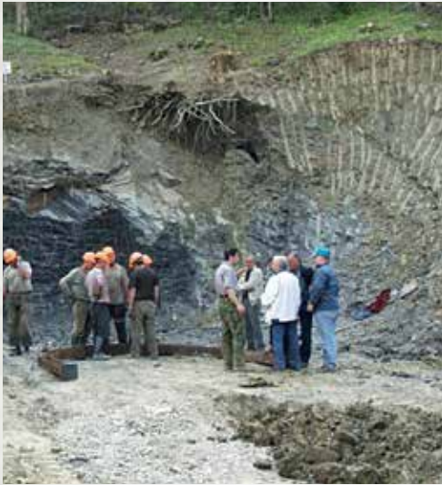
Место выхода тоннеля под хребтом Кобыла. Начало строительства.
