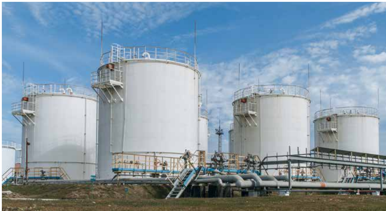
Пункт налива газового конденсата Каневского ГПУ. Г. Славянск-на-Кубани, 2013 г.
