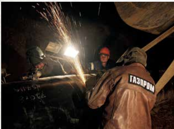
Капремонт газопровода «Майкоп – Самурская – Сочи». Ночная смена УАВР № 1. Электрогазосварщик В. Н. Чулахин за работой. Сентябрь, 2013 г.
