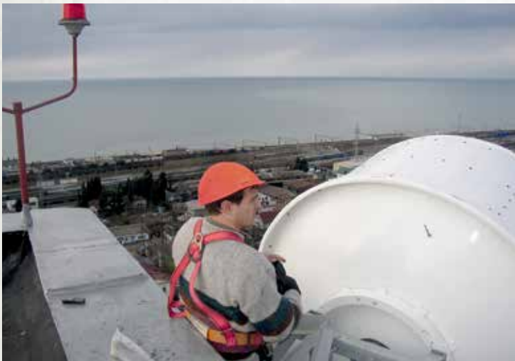
Монтаж современных приемо-передающих антенн радиорелейной линии «Comita»
