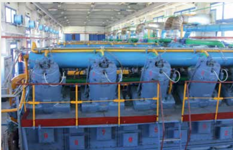
Сердце КС «Афипская» — машинный зал компрессорного цеха, 2015 г.
