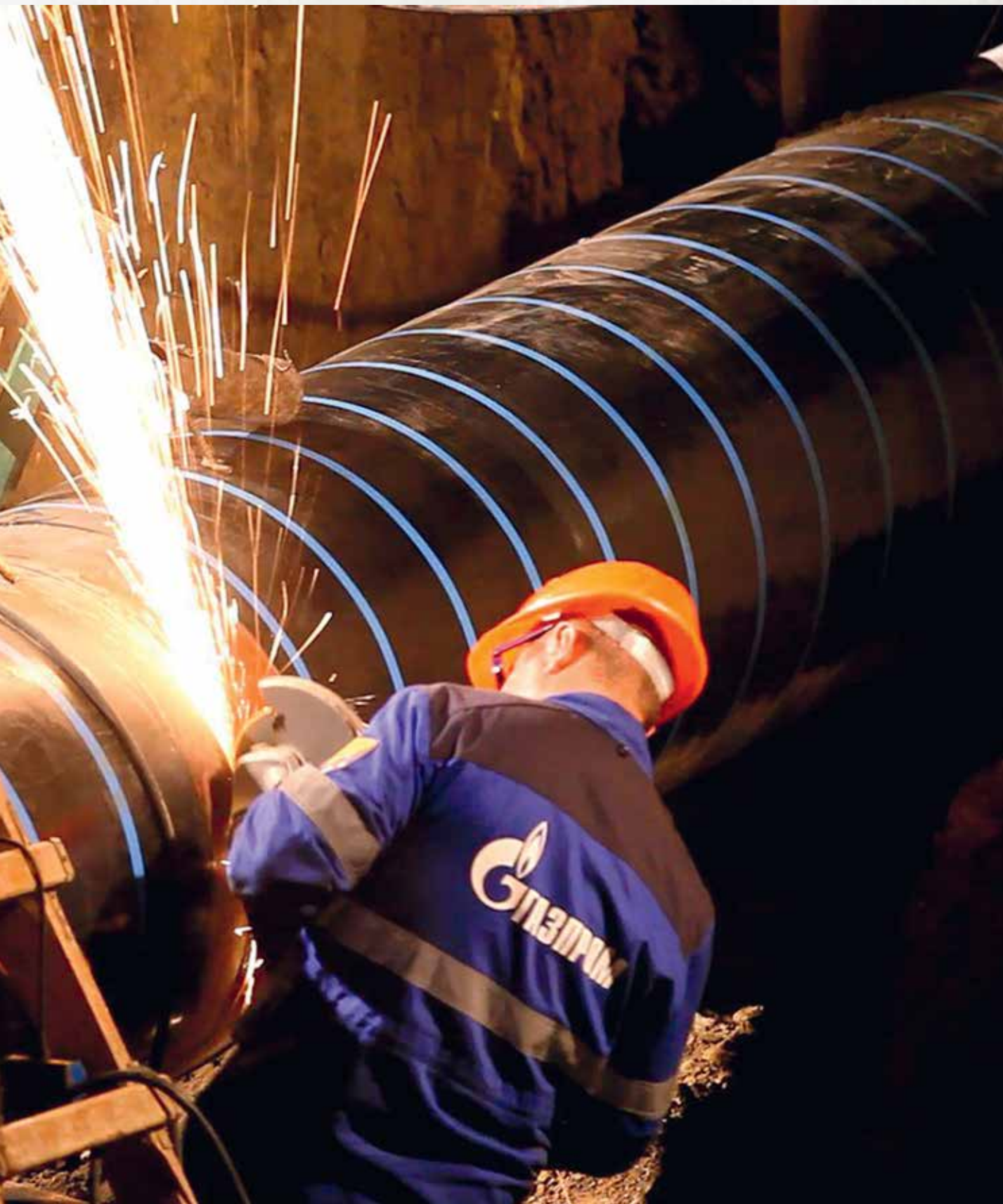
Огневые работы на газопроводе.
