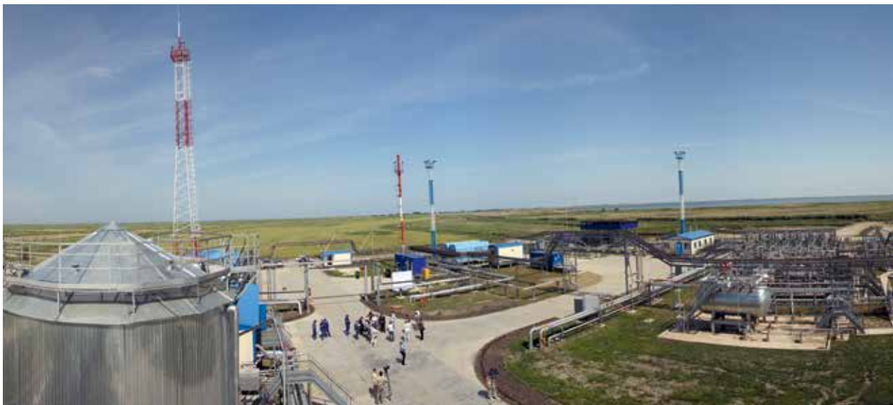
Установка подготовки газа-500 Каневского ГПУ, 2008 г.
