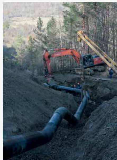
Капремонт газопровода «Майкоп – Самурская – Сочи» на горном участке, октябрь 2013 г.
