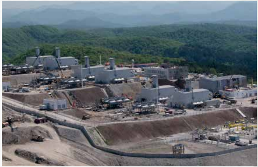
Строительство КС «Береговая», 2003 г.
