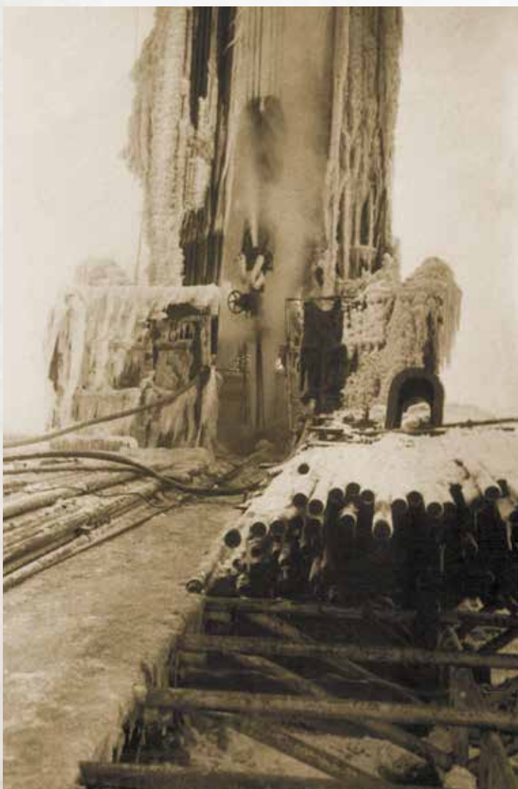
Скважина № 9 Крыловская. Открытый фонтан в процессе капитального ремонта, февраль 1965 г.
