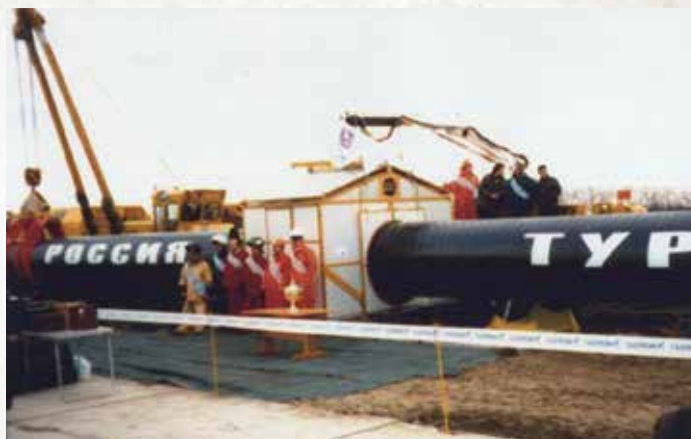
Сварка первого стыка газопровода «Россия – Турция», 3 февраля 2000 г., Украина г. Краснодар.
