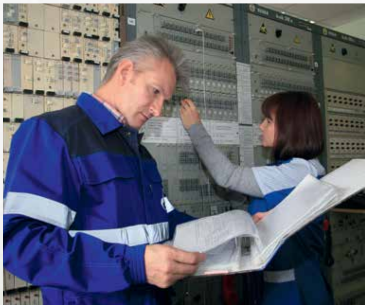
Линейно-аппаратный зал Аксайского участка Ростовского цеха. Измерения и регулировку аппаратуры проводят инженер электросвязи 1 категории В. И. Мецнеряков и Г. М. Кашкаха, электромонтер станционного оборудования и телефонной связи 5 разряда.
