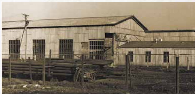
Сварочная эстакада (слева), слесарный участок (справа), где делали эстакадостроительный кран для морского бурения.
