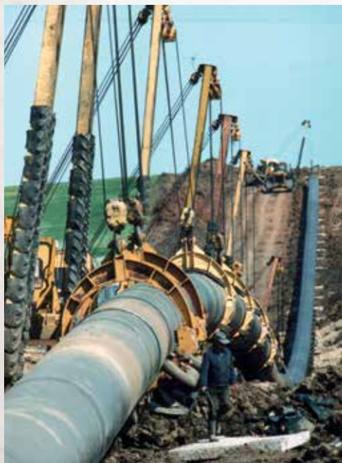
Строительство линейной части газопровода «Россия - Турция». 2001 г.
