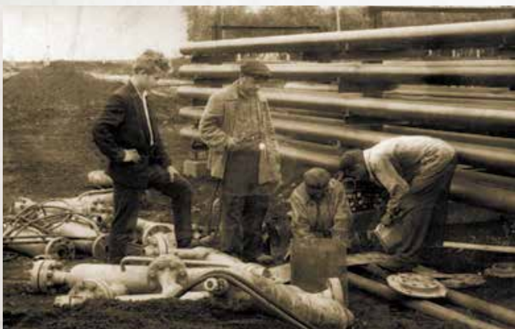
Монтаж установки низкотемпературной сепарации газа. Крыловской промысел, 1963 г.
