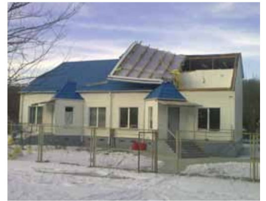
Дом оператора ГРС, пос. Тешебс
