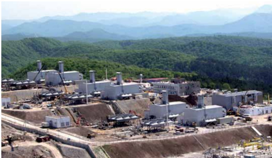
Из архива. 2002 г. Строительство КС «Береговая»
