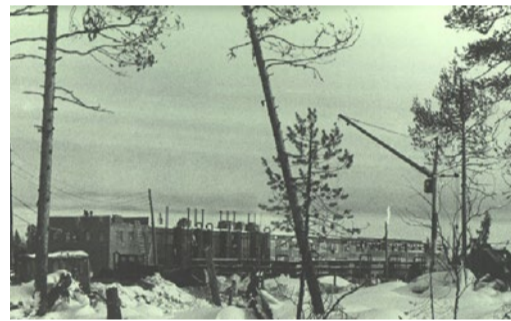
Фото из архива. 1969 год. Строительство первого сборного пункта (СП-2), ныне УКПП-2
