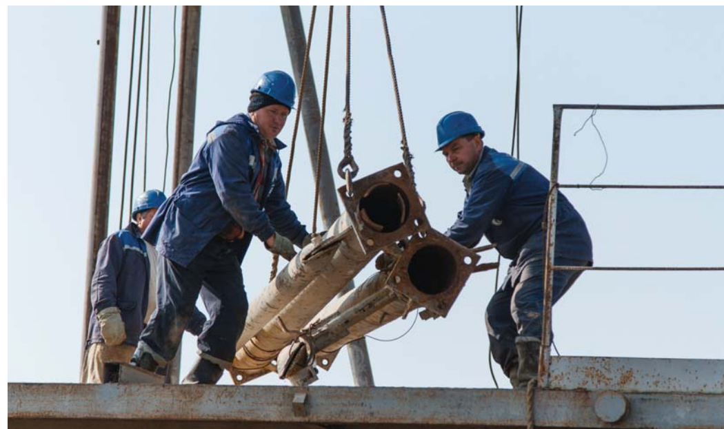
Вышко-монтажники собирают буровую вышку скважины 323. Фото: А. Старков
