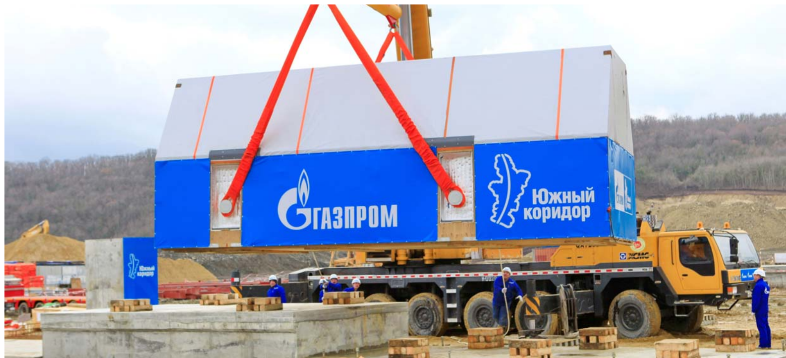
Строительная площадка компрессорной станции «Русская». Фото: В. Галль
