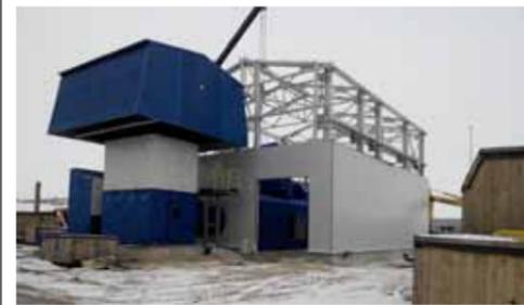
Продолжаются строительные работы на КС «Шахтинская». Станция располагается в зоне ответственности Ростовского ЛПУМГ и входит в систему газопроводов «Южный коридор» для обеспечения поставок газа в регионы РФ и в Европу. «Шахтинская» будет оснащена 5 ГПА мощностью 25 МВт каждый.
