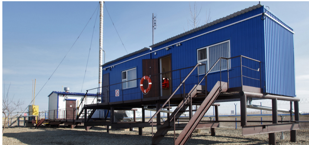
Так выглядит вагончик оператора на ГУ № 2 Бейсугского месторождения сегодня
