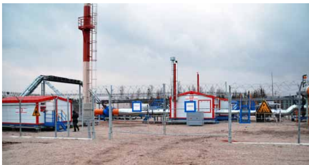
Замерной узел подачи попутного нефтяного газа из газопровода «Уса – Печора» ООО «ЛУКОЙЛ-Коми» в газотранспортную систему ООО «Газпром добыча Краснодар»
