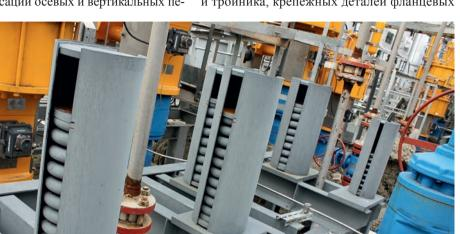
соединений адсорберов и монтаж опорноподвесной системы. Установленная система включает 23 скользящие опоры, 24 пружинные и одну шарнирную. Проектирование и разработка данной конструкции — это несколько месяцев упорной работы коллективов ОАО «Оргэнергогаз» и ПАО «ОМЗ» с непосредственным участием на каждом этапе специалистов «трансгаза».
