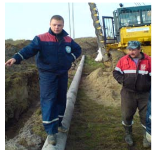
Константин (слева) на строительстве газопровода (Калининградская область)
