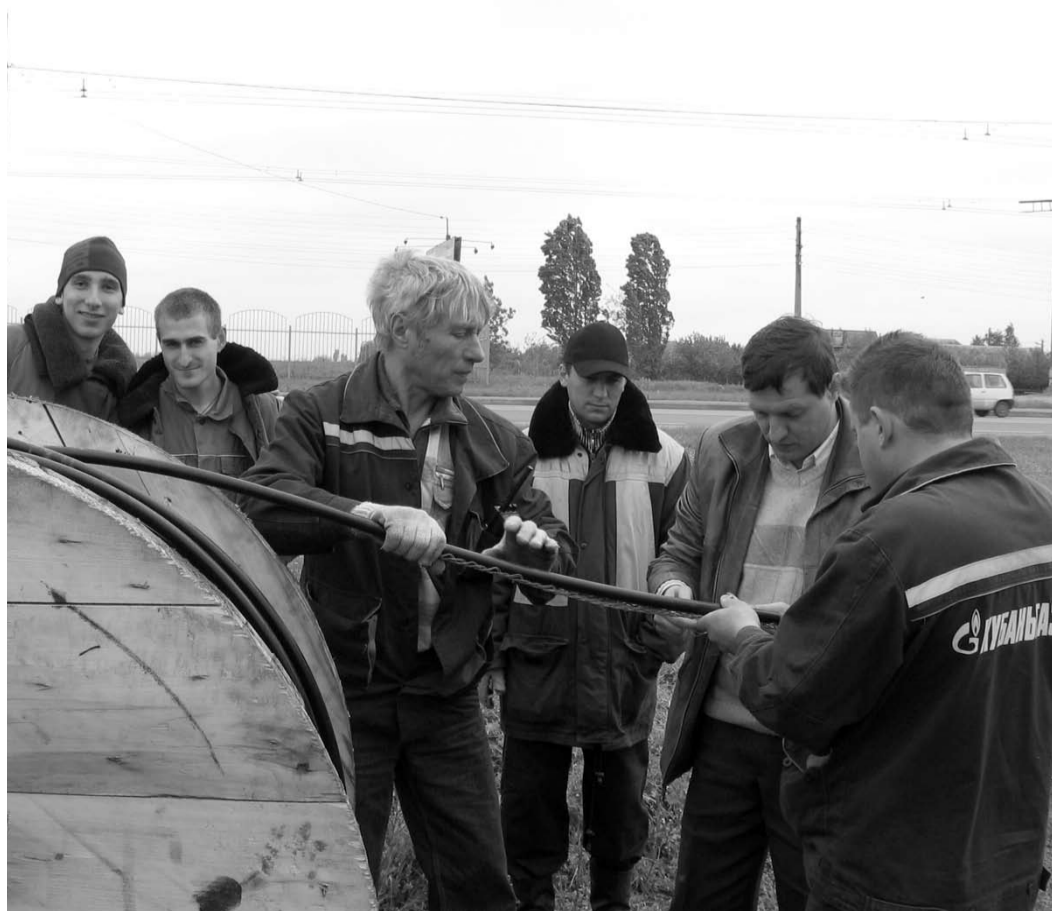
Ремонтные работы на кабельной линии связи (второй справа - Владимир Корниенко)
