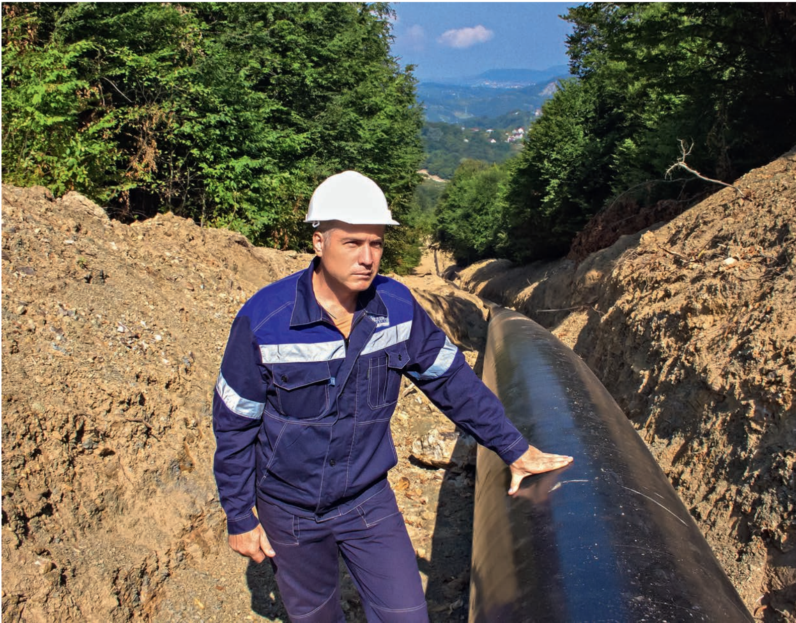
Ведущий инженер Майкопского ЛПУМГ Виктор Гаманков на участке капитального ремонта газопровода «Майкоп – Самурская – Сочи». Автор фото Татьяна Зезюлина
